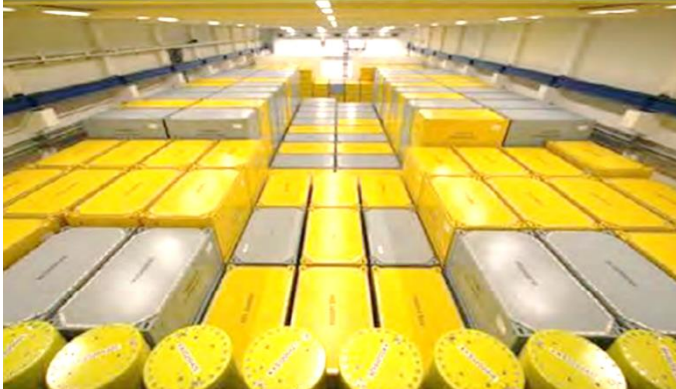
Abbildung 5: Zwischenlager LarA am Standort Stade
