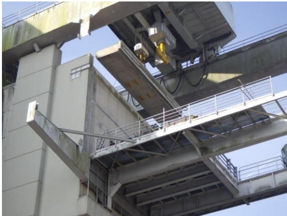
Abbildung 5: Demontage der Bühne am Halbportalkran
