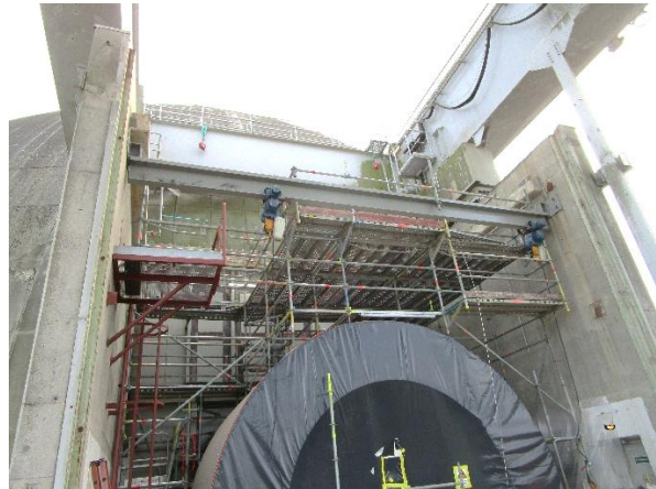
Abbildung 6: Demontierte Materialschleuse bereit zum Ablassen
