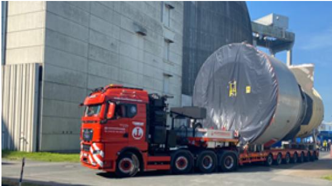
Abbildung 8: Abtransport der Materialschleuse ins Maschinenhaus
