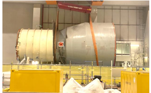
Abbildung 9: Ankunft der Materialschleuse am Zerlegeplatz im Maschinenhaus
