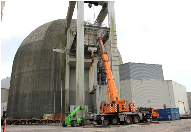
Abbildung 3: Der Flugzeugabweiser wird abgebaut...
