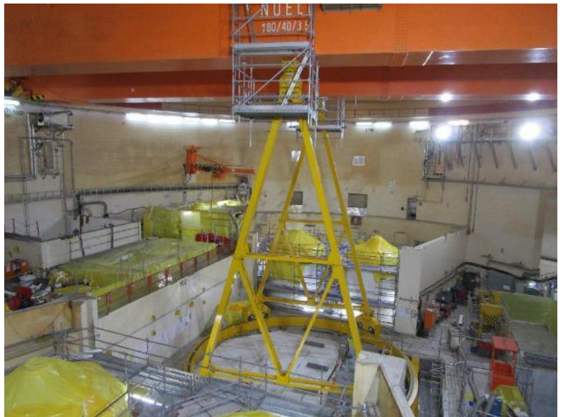
Abbildung 12: Einbau und Abnahme der Ringbahn und Mittelstütze
