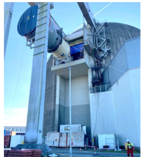
Abbildung 7: Die Materialschleuse wird herausgehoben
