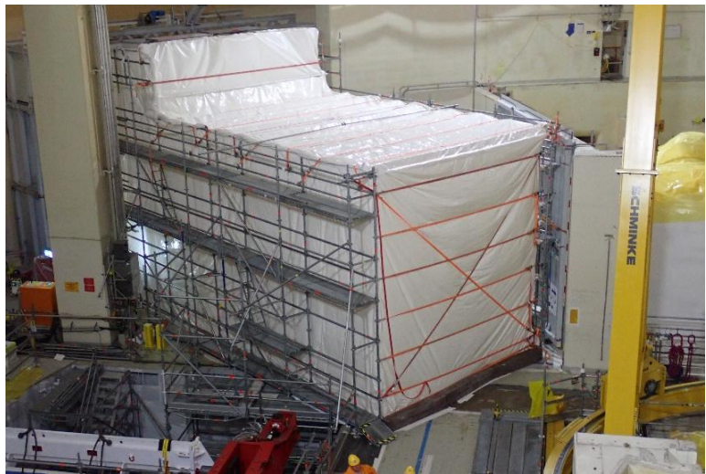
Abbildung 14: Zusätzliche innere Einhausung als zuverlässiger Kontrollbereichsabschluss
