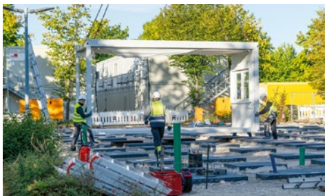
Aufbau der ersten Containermodule für das neue Servicefirmengebäude
