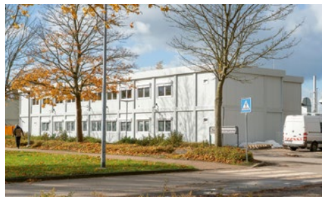
Ende 2025 war das neue Bürogebäude bereits errichtet.
