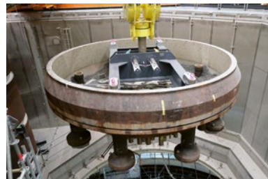
Hub der 110 t schweren Bodenkalotte
