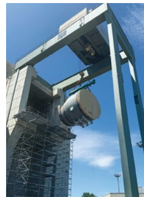
Absenken des Außenhauptes mittels Halbportalkran
