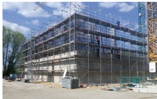
Die 85 cm starken Wände der TBH bestehen aus Stahlbeton.
