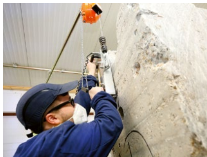
Bearbeitung eines Betonsegments im Reststoffbehandlungszentrum
