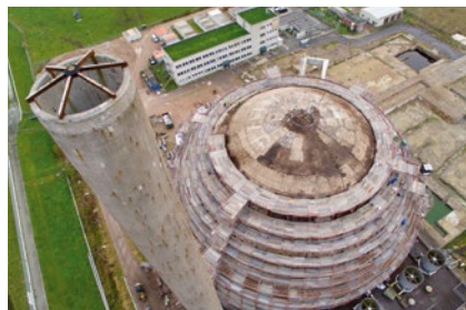
Blick auf das eingerüstete Reaktorgebäude
