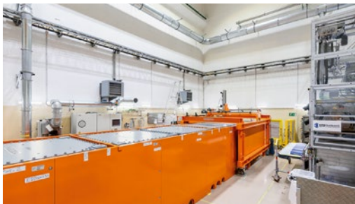
Die Betonierstraße mit fertig verfüllten und verschlossenen Konrad-Containern
