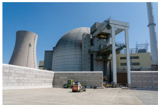
Die Containerlagerfläche nach Errichtung der Wände
