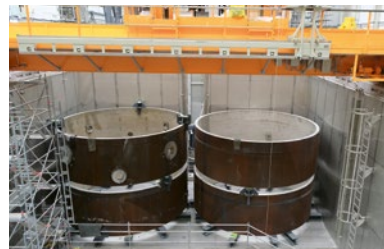
Gestapelte Ringsegmente des Reaktordruckbehälters im Flutraum
