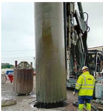
Bohrarbeiten für einen der insgesamt 140 Pfähle, auf denen die TBH errichtet wurde
