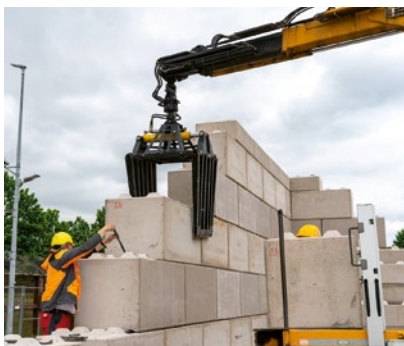
Aufbau der massiven Betonblockwände
