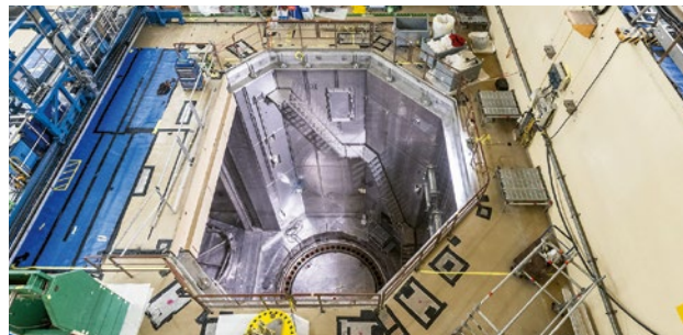
Der Beckenflur während des Rückbaus, 2023
