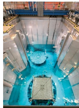
Seitlicher Blick auf den Abstellraum mit Drehtisch (obere Bildhälfte) und den Reaktorraum mit Oberem Kerngerüst (untere Bildhälfte). Die rechteckige Fläche ist eine Traverse zum Heben des Kerngerüsts.
