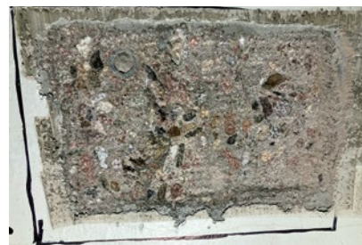
Wandbereich im KWW nach der Entschichtung: Am Bildrand ist die gelbliche Dekontaminationsbeschichtung noch gut erkennbar.
