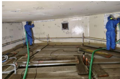
Fräsarbeiten im unteren Ringraum
