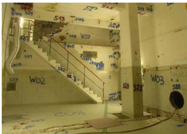
Abbildung 6: freizumessender Raum mit Probenahmestellen (PreussenElektra GmbH, Kernkraftwerk Würzgassen)
