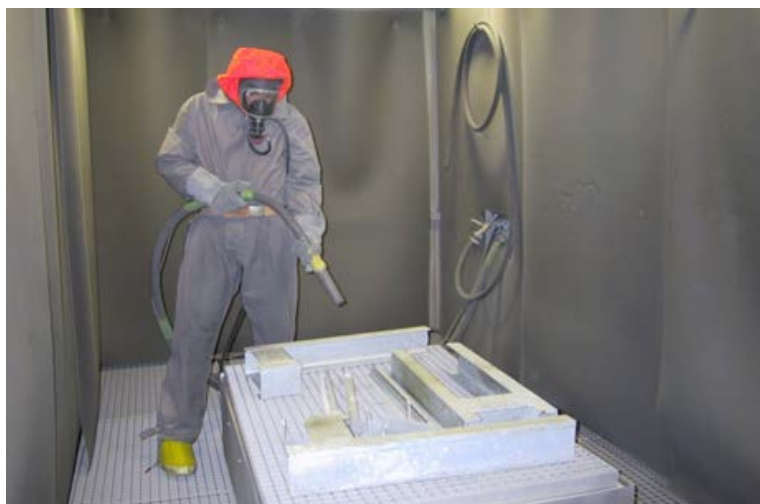
Abbildung 9: Mediumstrahlen von metallischen Komponenten (PreussenElektra GmbH, Kernkraftwerk Würgassen)
