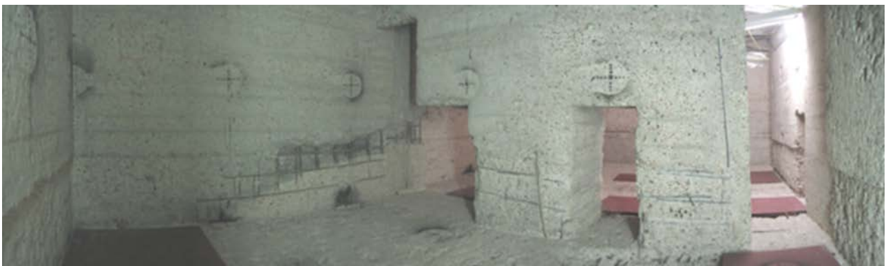
Abbildung 4: Dekontaminierte Gebäudestrukturen (PreussenElektra GmbH, Kernkraftwerk Würiggassen)
