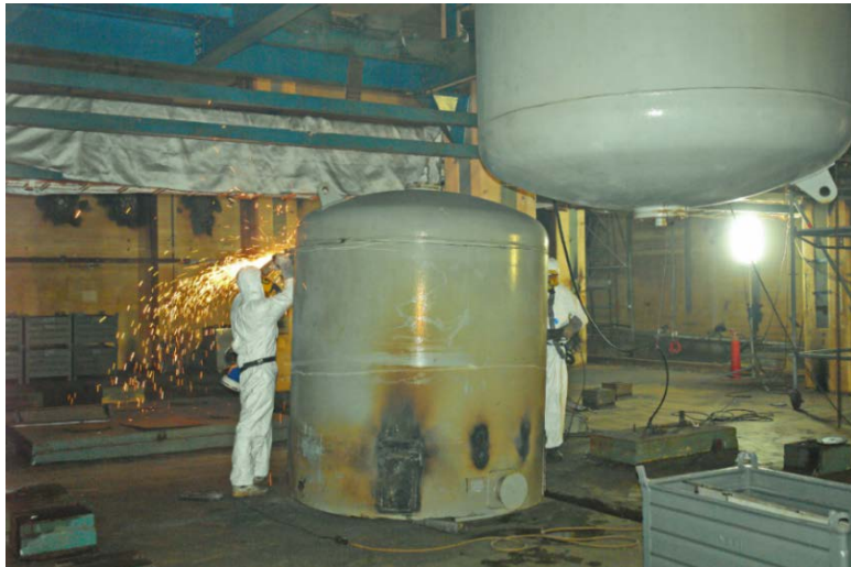
Abbildung 8: Abbau und Zerlegung von Behältern (EWN Entsorgungswerk für Nuklearanlagen GmbH, Kernkraftwerk Greifswald)
