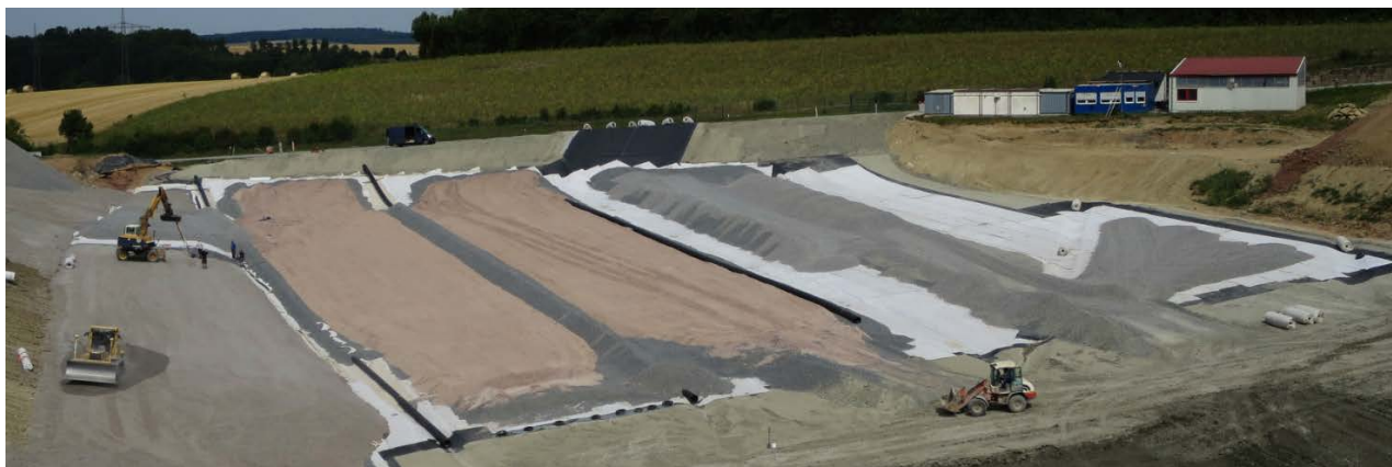
Abbildung 12: Vorbereitung einer Deponiefläche für die spätere Ablagerung konventioneller und freigegebener Abfälle (Abfallwirtschaftsgesellschaft des Neckar-Odenwald-Kreises)
